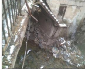
Bitlis Çayı üzerindeki kaldırılması gereken yapı-7
