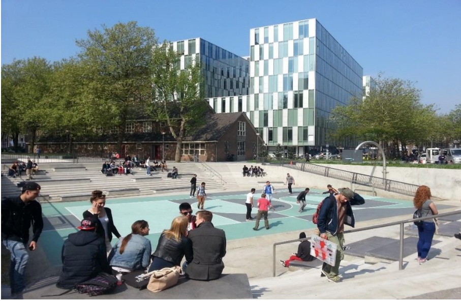
Resim 2: 1.7 milyon litre su tutma kapasitesine sahip ve üç havuzdan oluşan Bentemplein Su Meydanı (Su Plazası), şiddetli yağışların olmadığı zamanlarda amfi tiyatro, oyun ve spor alanı olarak kullanılıyor. 2013 yılında açılan meydan, dünyanın ilk su meydanı olma özelliğine sahip. ( https://www.c40.org/case_studies/bentemplein-water-square-an-innovative-way-to-prevent-urban-flooding-in-rotterdam , 06.8.2021)
