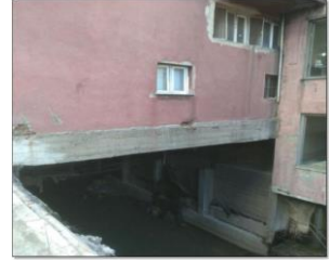
Bitlis Çayı üzerindeki kaldırılması gereken yapı-3
