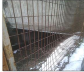
Bitlis Çayı üzerindeki kaldırılması gereken yapı-2
