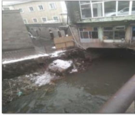
Bitlis Çayı üzerindeki kaldırılması gereken yapı-4
