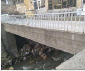
Bitlis Çayı üzerindeki kaldırılması gereken yapı-1
