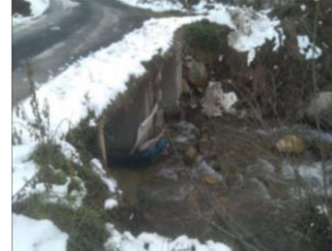
Bitlis Çayı üzerindeki kaldırılması gereken yapı
