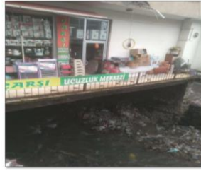
Bitlis Çayı üzerindeki kaldırılması gereken yapı-5
