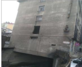
Bitlis Çayı üzerindeki kaldırılması gereken yapı-8
