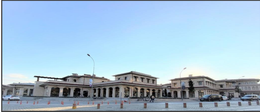
Fotoğraf 44: Mevlâna Çarşısı ve Altın Çarşısı'nın Yerine Yapılan Binalardan Bir Görünüm
