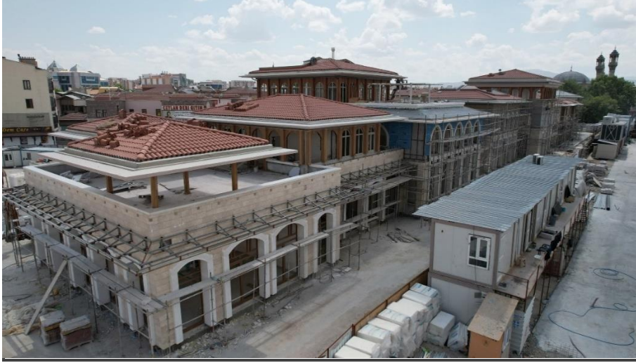
Fotoğraf 43: Mevlâna Çarşısı ve Altın Çarşısı'nın Yerine Yapılan Binaların Yapım Aşamasından Görünüm
