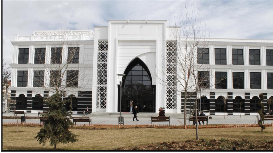
Fotoğraf 71: Konya İl Halk Kütüphanesi Binası
